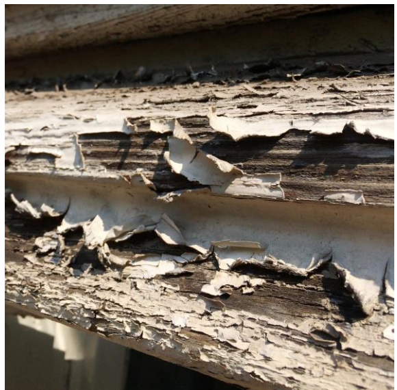
Detale zachowanej oryginalnej historycznej stolarki okiennej – widoczne zniszczenia oraz wypracowania związane z wiekiem i intensywnym użytkowaniem elementów ruchomych.
