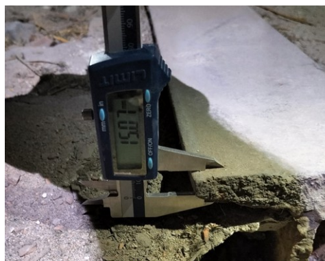
Fot. 8 - Belka stropu nad IIp. Pomiar gr. półki.
