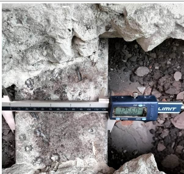
Fot. 3 - Odkrywka stropu nad I piętrem. Pomiar szerokości belki stalowej.
