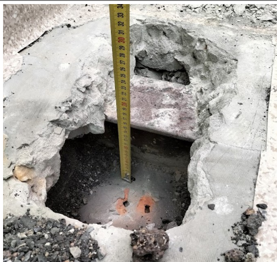
Fot. 2 - Odkrywka stropu nad I piętrem. Pomiar grubości stropu.
