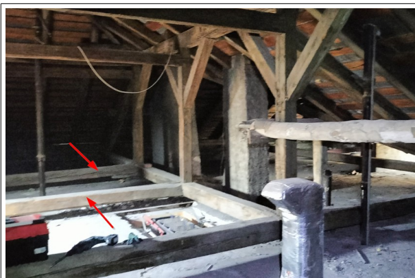
Fot. 9 - Widok ogólny więźby dachowej. Zaznaczono nadmiernie ugięte belki tramowe.
