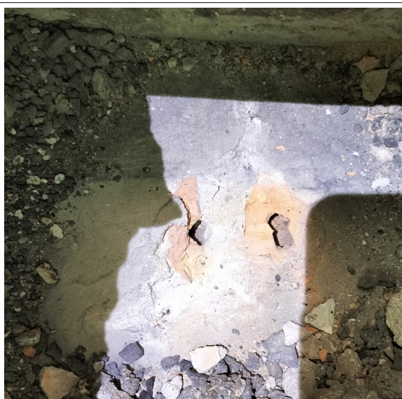
Fot. 4 - Odkrywka stropu nad I piętrem. Widok ceglanej płyty stropowej.
