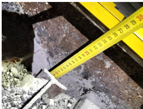
Fot. 6 - Pomiar gr. stropu nad IIp.
