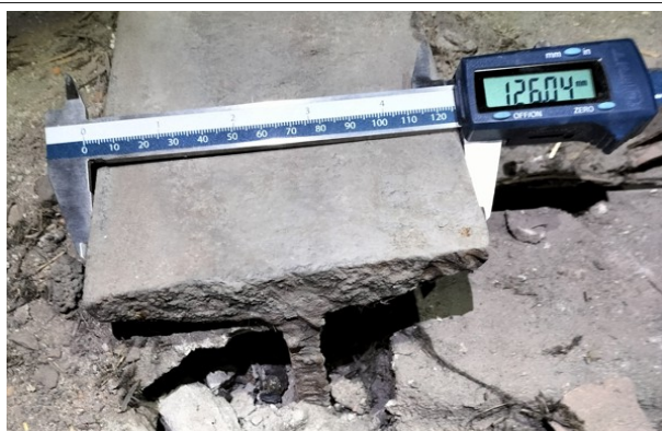
Fot. 7 - Belka stropu nad IIp. Pomiar szer. półki.
