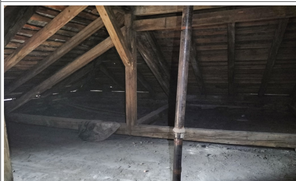
Fot. 11 - Widok ugiętej belki tramowej.
