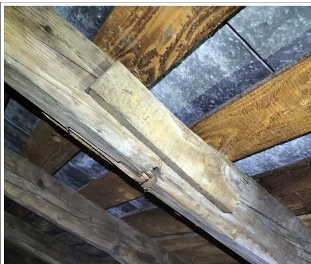
Fot. 13 - Widok nieprawidłowego połączenia krokwi
