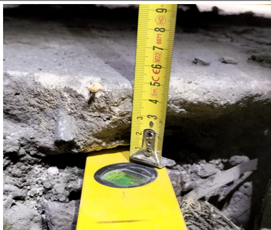
Fot. 5 - Strop nad IIp. Pomiar grubości szlichty
